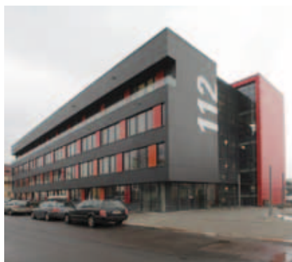
Das Brand- und Katastrophenschutzzentrum Dresden Übigau nutzt Wärme aus dem Kanal.
