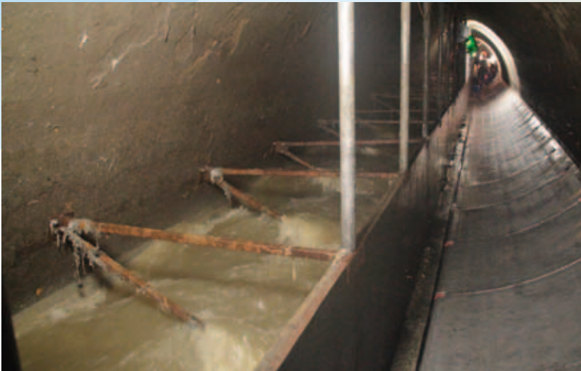
Einbau der Wärmetauscher bei vollem Kanalbetrieb.
