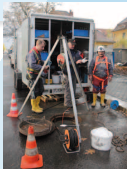
Das Montageteam des Herstellers der Wärmeüber-tragerelemente.
